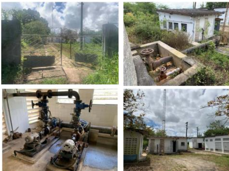
Vistas da área externa da Área 1600 e interna da estação elevatória EE-10
