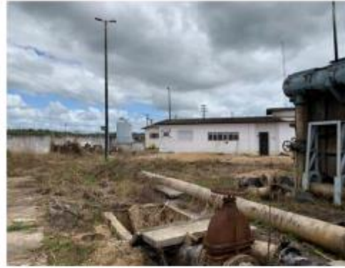
Casa de Química
