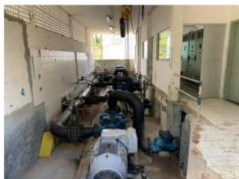
Acham-se instalados na EE-4, três conjuntos elevatórios, sendo um de reserva. Estes conjuntos recalcam para a área 600, através de uma linha com extensão de 5.300 m composta de duas tubulações paralelas com diâmetro 300 mm. As características dos conjuntos elevatórios são apresentadas a seguir.
