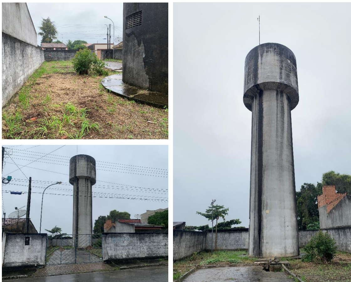
Vista geral do Reservatório RE-2 de Areia Branca e do acesso à área de implantação
