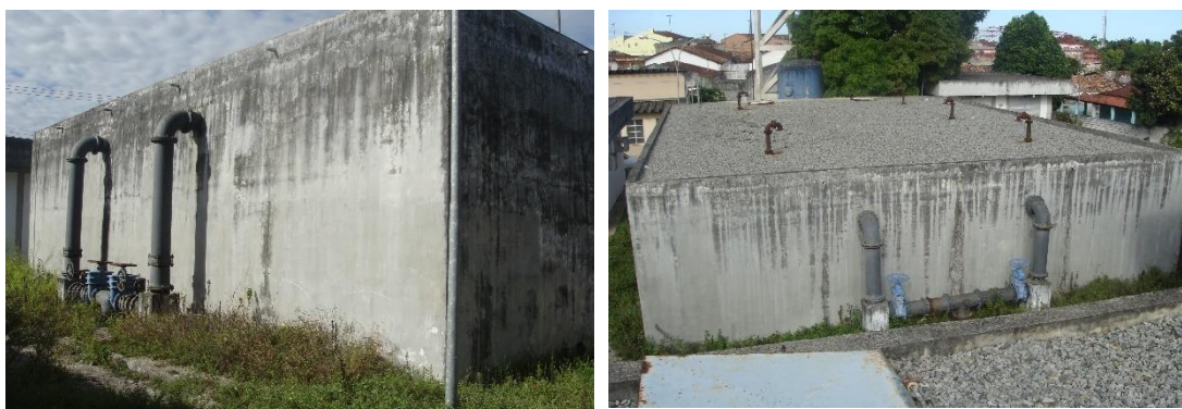
Vistas gerais do RAP de água tratada de 700 m 3 de capacidade
