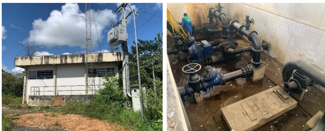
Vistas externas e internas da Elevatória de água bruta da Cajaíba
