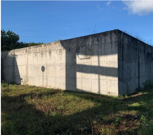
Vista do reservatório apoiado novo
