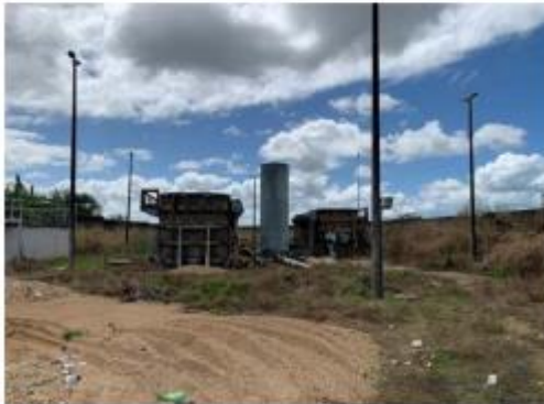
Vista geral da área da ETA
