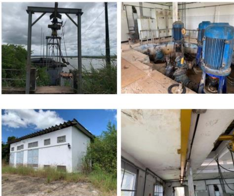
Figura 7 - Vistas gerais externas e interna da estação elevatória e externa da subestação elétrica
