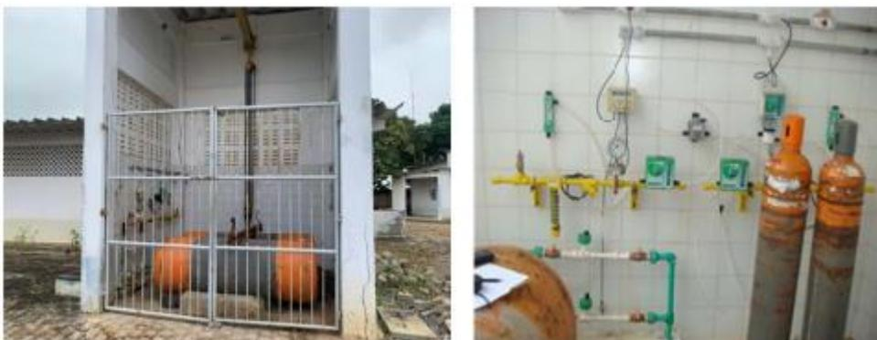
A unidade de cloração é composta por injetor, clorador automatizado e cilindros metálicos de cloro gasoso. Segundo informações do pessoal de operação o sistema de cloração está operando normalmente.
