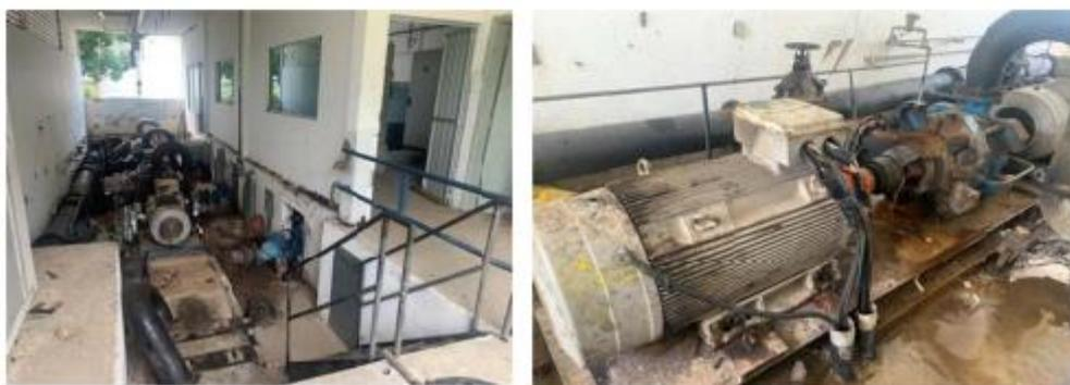
A EE3 conta com três conjuntos elevatórios, sendo um de reserva, recalcando para a Área 500, através de uma linha de recalque composta de duas linhas paralelas com diâmetro de 350 mm e extensão de 8.426 m até a torre T-2. As características dos conjuntos elevatórios são apresentadas a seguir.
