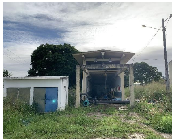
Vista externa da estação elevatória
