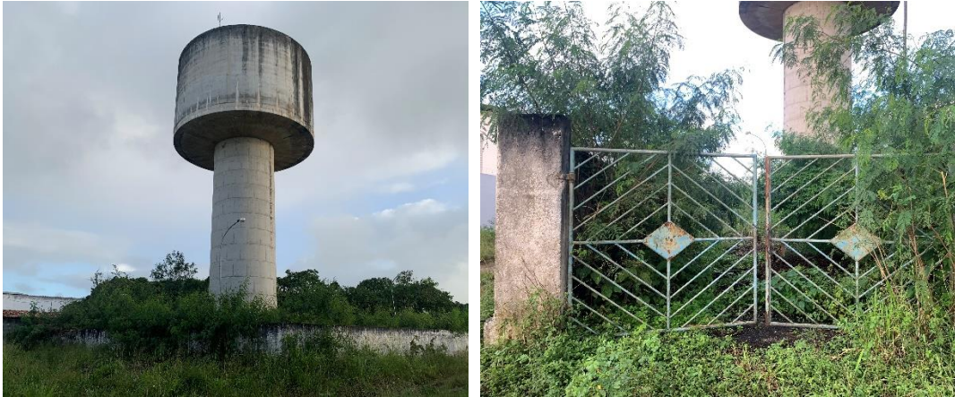
Reservatório RE-03 e área de implantação
