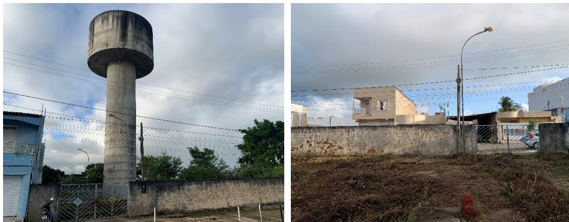
Vista geral do Reservatório RE-2 e do acesso à área do reservatório
