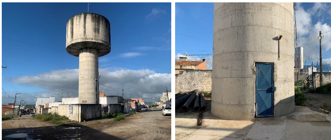
Vista geral do Reservatório RE-5 e do acesso ao reservatório
