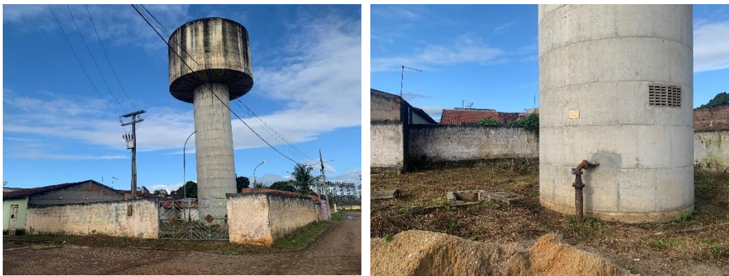
Vistas gerais do Reservatório RE-4 e da área de implantação
