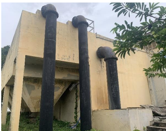
Vista da caixa de areia e poço de sucção
