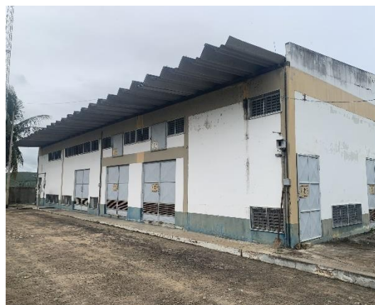
Vista externa da subestação elétrica
