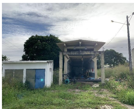
Vista externa da estação elevatória
