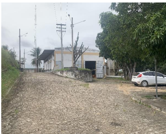
Vista externa da casa de bombas
