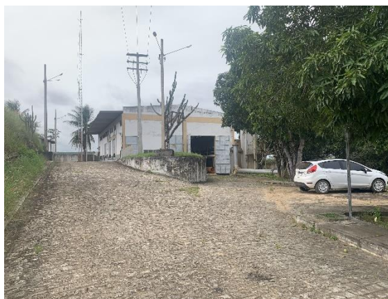
Vista externa da casa de bombas
