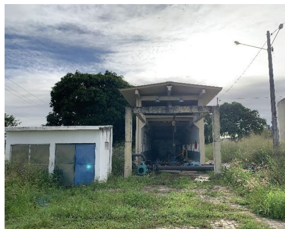
Vista externa da estação elevatória
