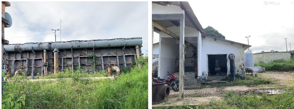
Vista geral da ETA, reservatório de água tratada e Casa de Química
