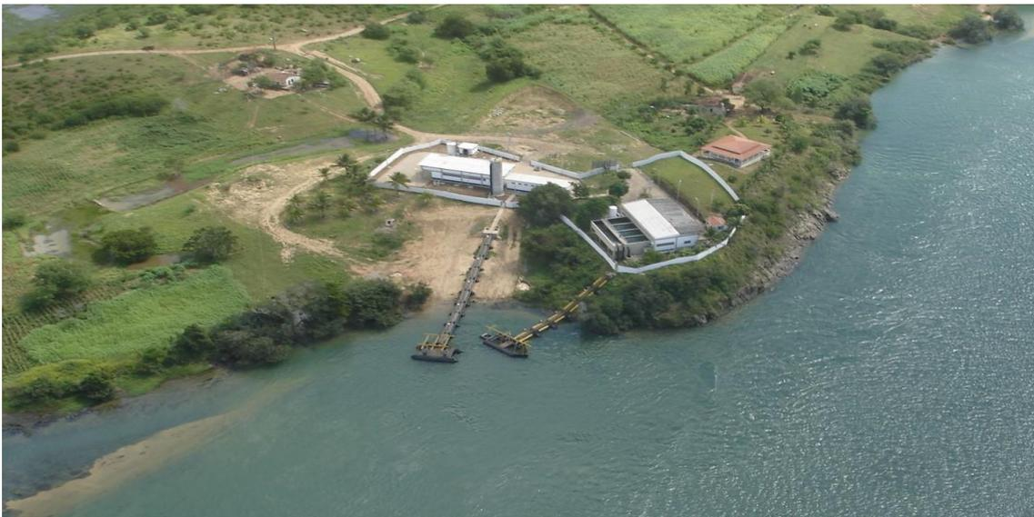
Através de uma adutora de 5.850 metros de extensão, construída com tubos de ferro fundido dúctil de diâmetro 600 mm, a água bruta recalçada pela EEOA chega à ETA Semiárido, construída na área de propriedade da DESO que abriga a Estação de Tratamento de Água do Alto Sertão.
