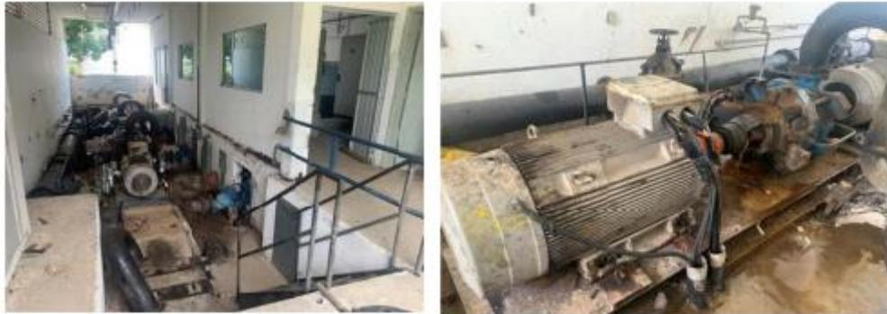
A EE3 conta com três conjuntos elevatórios, sendo um de reserva, recalcando para a Área 500, através de uma linha de recalque composta de duas linhas paralelas com diâmetro de 350 mm e extensão de 8.426 m até a torre T-2. As características dos conjuntos elevatórios são apresentadas a seguir.
