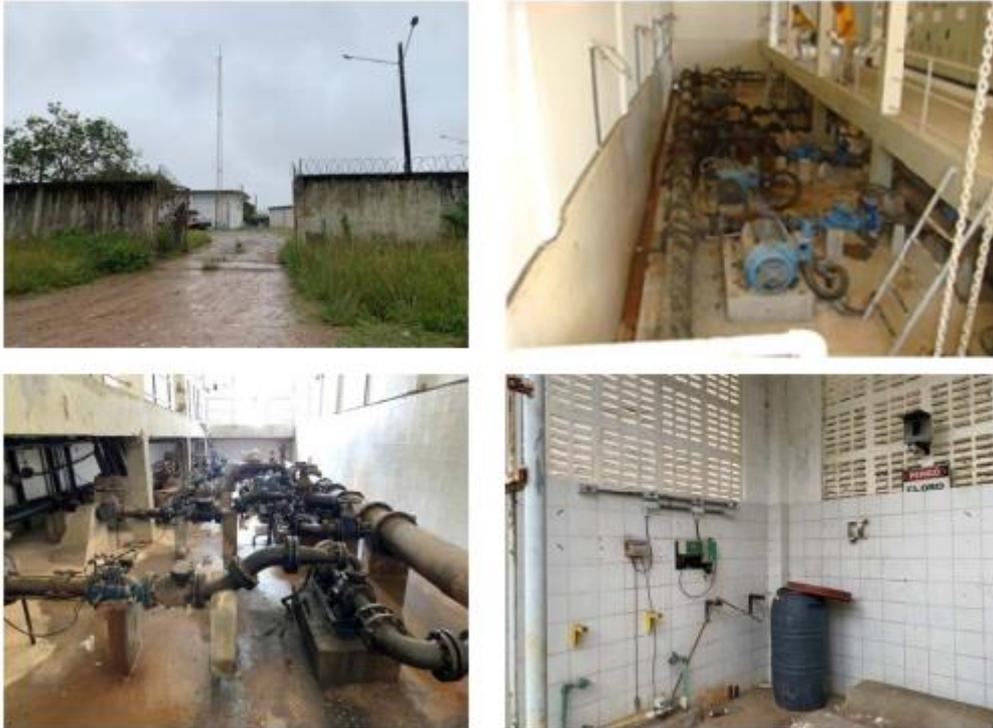
Junto à estação elevatória está instalado um posto de cloração automatizado, composto por injetor, clorador e cilindros metálicos de gás cloro. Este sistema foi implantado juntamente com a reforma da Área, concluída em 2011 e acha-se desativado no momento.
