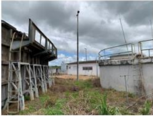
Reservatório de água de lavagem
