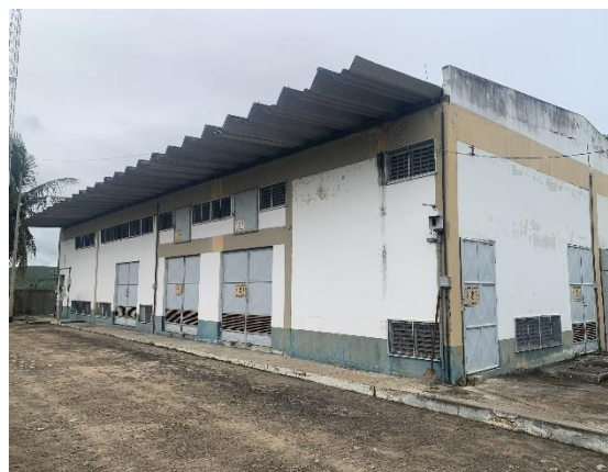
Vista externa da subestação elétrica
