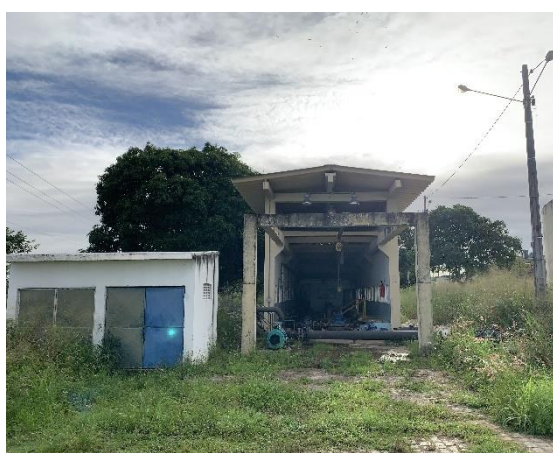
Vista externa da estação elevatória
