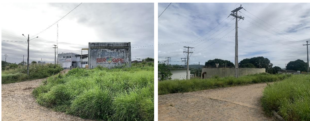
Vista da ETA Semiárido ao fundo, reservatório de água tratada e EE-1
