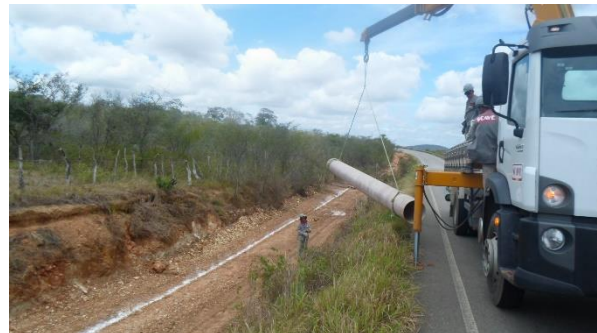
Adutora da CP para Ribeirópolis e Moita Bonita diâmetro 400 mm
