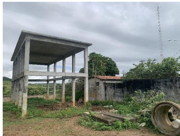
Subestação do Booster B3
