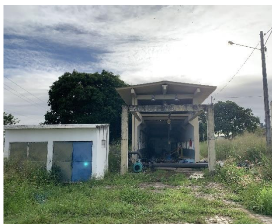
Vista externa da estação elevatória
