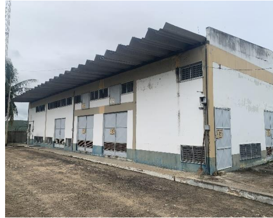
Vista externa da subestação elétrica
