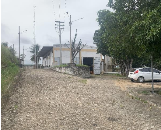
Vista externa da casa de bombas
